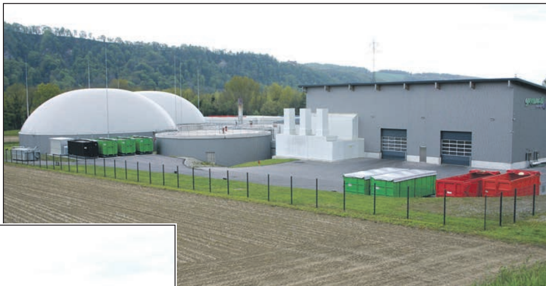
L'installation de production de biogaz
