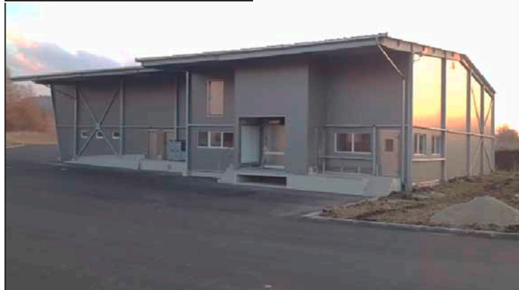
Le nouveau bâtiment
