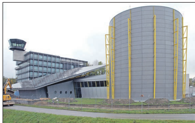
Le nouveau bâtiment en phase de finition
